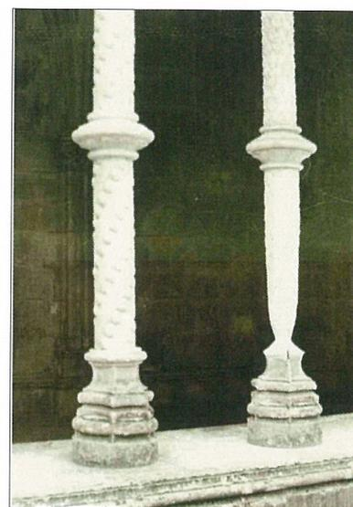
**figura 7** Mosteiro de Santa Cruz em Coimbra. Colunas corroidas de forma diferencial.
